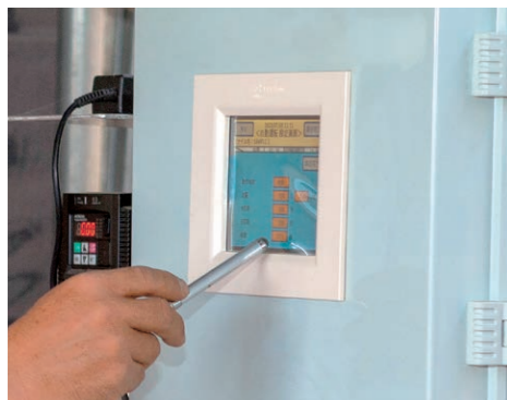
すべてのビニールハウスに自動灌水装置を設置。パソコンで土壌の水分を確認して、灌水量を調節しています。
