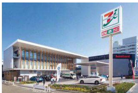
水素ステーション併設のセブン-イレブン大田区池上8丁目店
