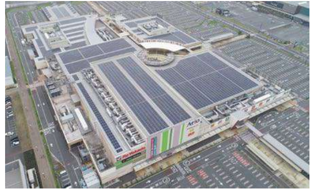
屋根上太陽光パネル (Ario 市原店)
