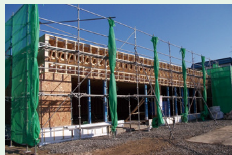
建設中の木造店舗
