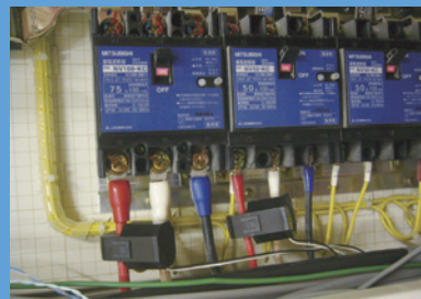
スマートセンサー（電気の「見える化」のための消費電力量の計測器）
