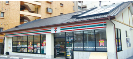
トップライトや太陽光発電を採り入れた環境配慮型店舗
