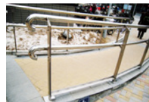
車椅子利用者に配慮した 店舗入口のスロープ
