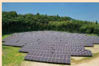
千葉若葉太陽光発電所
