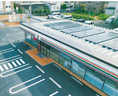
セブン・イレブン店舗に設置した太陽光パネルと蓄電池。
