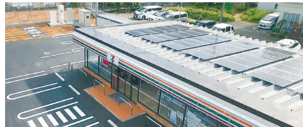
上空から見た実験店舗。屋根には太陽光パネル、駐車場奥には蓄電池が並びます。
