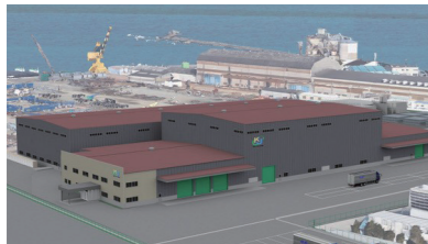
協栄J&T環境が建設中の「西日本PETボトルMRセンター」の完成イメージ。
