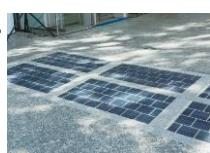
100m<sup>2</sup>敷設時発電量約10,000kwh/年
