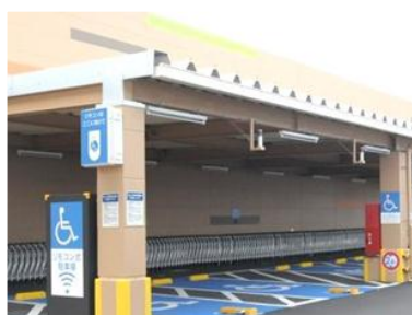
リモコン式車椅子専用駐車場
