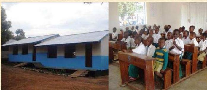
建設された校舎と授業の様子
