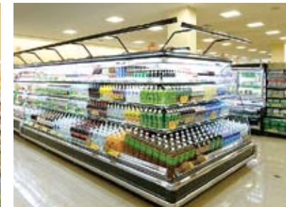
低温に強く、紫外線を出さないLED照明を冷ケースに活用し、省エネにも配慮。上部に張り出したキャノピー照明が、各棚段の商品を明るく照らします。バックヤードにも外光を取り入れ、省エネを推進。
