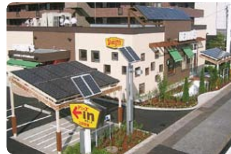
店舗の屋根や駐車場にソーラーパネルを装備。
