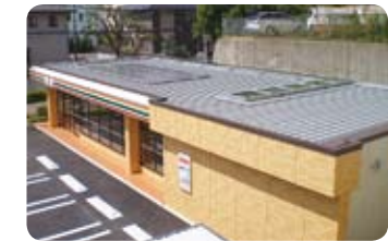
屋根には太陽光発電の大型パネルを装備。
