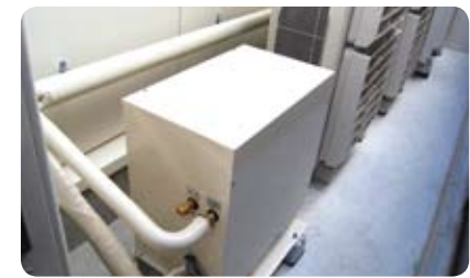
冷凍機の廃熱を使用した世界初の給湯設備。
