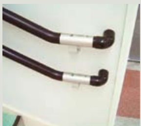
階段の手すりは異なる高さで2本設置し、身長に合わせて使いやすくしています。
