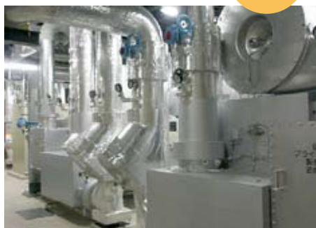
夜間電力を利用して製氷した氷を冷房に使用する水蓄熱システム。
