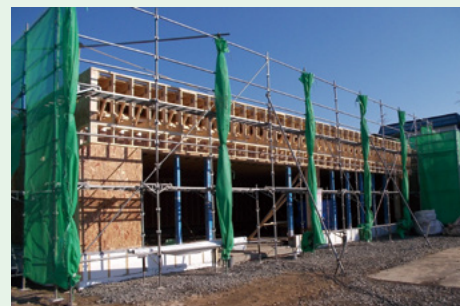
建設中の木造店舗
