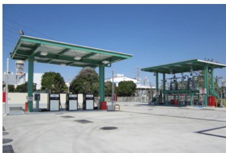
燃料備蓄基地
