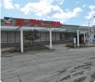
40センチの浸水被害と駐車場にはヘドロが堆積した大街道店。一時休業をしていましたが、4月24日に全館再開しました。
