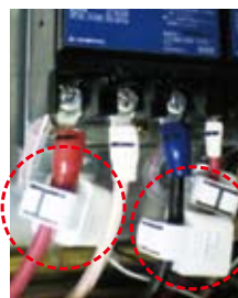
分電盤にスマートセンサーを装着し、消費電力量をモニターしています。(開発:産業技術総合研究所)
