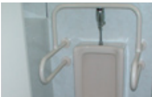
手すりを設置したトイレ
